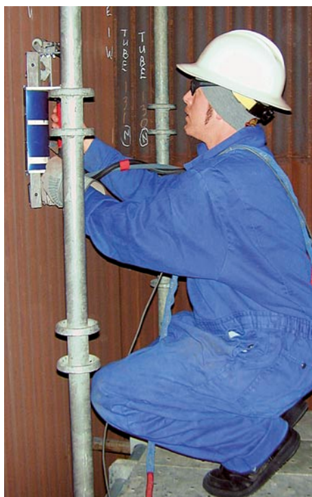
Рис. 5. ELF-контроль бойлерных труб
