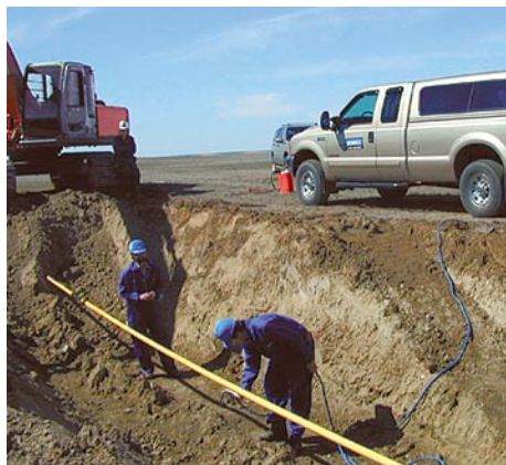
Рис. 2. Использование ELF-преобразователя для внешнего контроля на трубе \varnothing 50 мм
